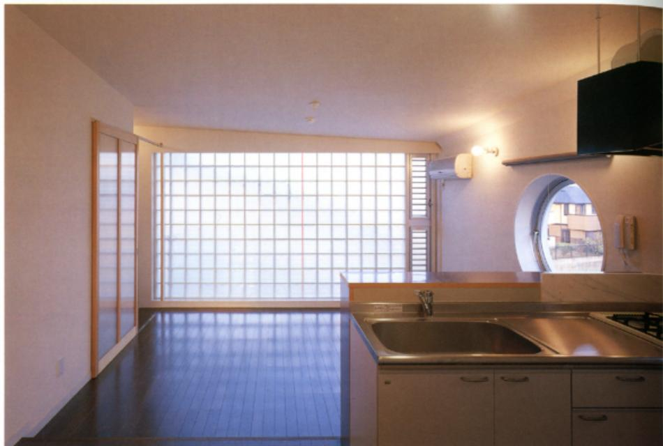
フラットタイプの住戸 (F棟204号室) 内部。左側が玄関。2階住戸は天井高が2,300mm~3,300mm程度に配なりの高さをもつ。右上の斜めの天井部分は、壁面とスラブの接合部のハンダ。床は厚さ12mmフローリング。壁・天井はビニルクロス貼りで、各住戸共通の仕上げとなっている。(\*)
